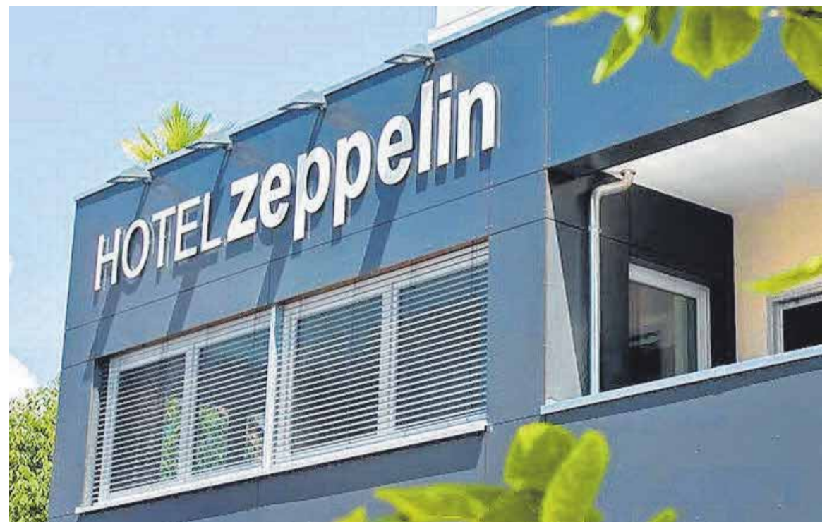
Das Gebäude steht von außen und von innen bestens da. Der letzte große Umbau erfolgte im Winter 2021/2022. Auch während der Pandemie konnten weiterhin ausgezeichnete Umsätze mit dem Hotelbetrieb generiert werden.
